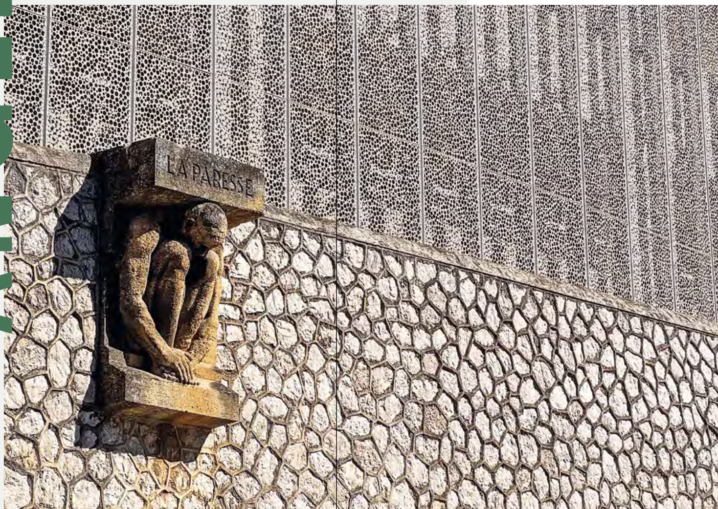
← Le mur d'enceinte coiffé du pare-vue.
