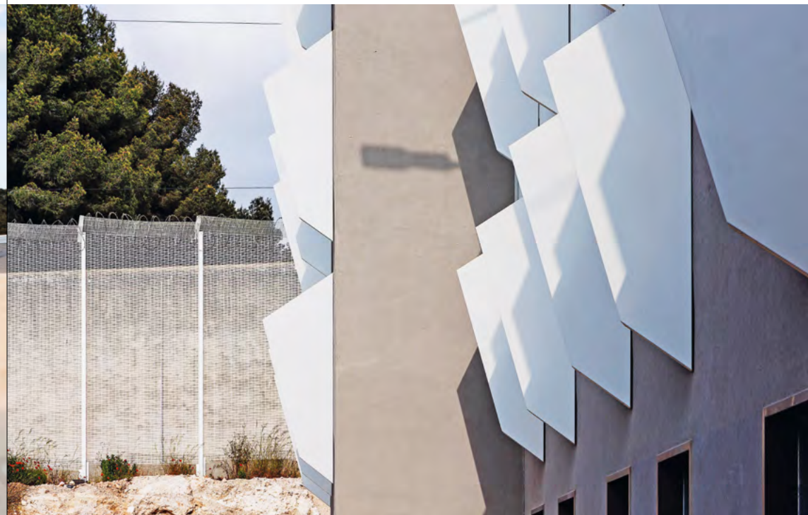
↑ Écaïlles des fenêtres, Baumettes III.
