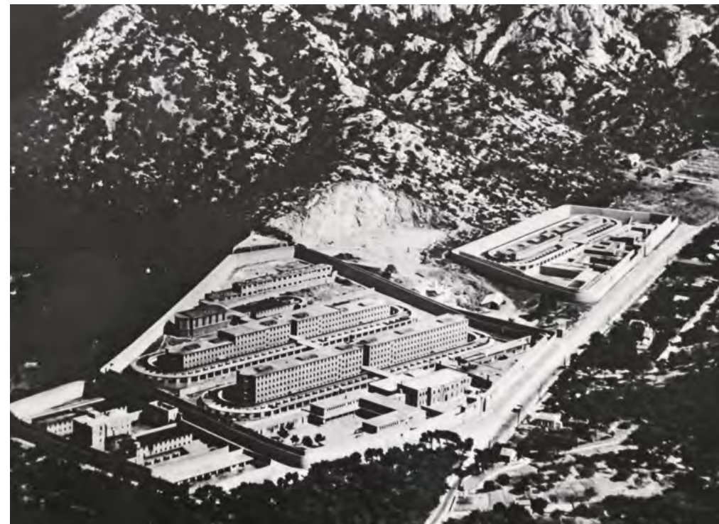
↑ Vue aérienne des Baumettes dans les années 1960.
