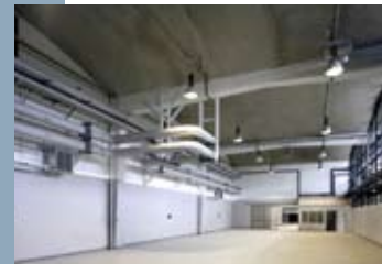
▲ Les ateliers rénovés accueilleront les concessionnaires en partenariat avec la maison d'arrêt.
