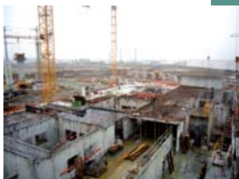
^ > Le chantier de la maison d'arrêt.
