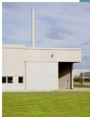
^ La porte d'entrée principale où les deux seuls accès à la maison d'arrêt se trouvent dans le champ de surveillance des deux miradors.
