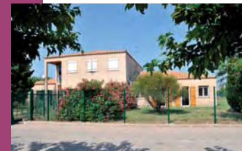
^ Le mess, bâtiment dédié aux personnels pénitentiaires.
