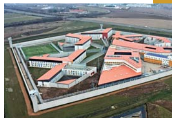
^ Vue de l'établissement en cours de construction.
