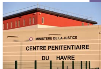
^ Détail de l'enceinte.
