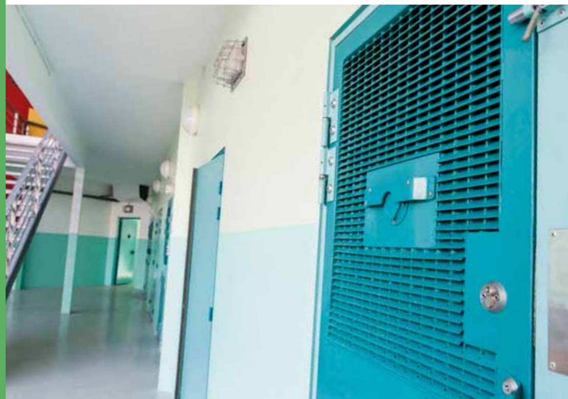
^ Des coursives desservent les nouvelles cellules.
