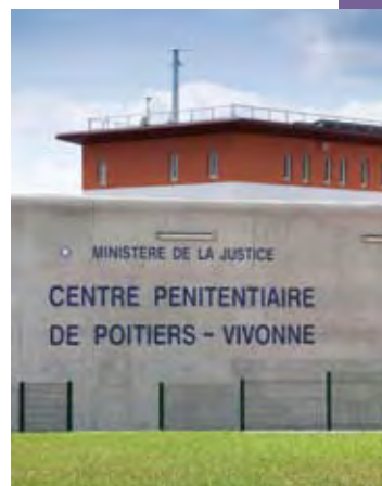
▲ La porte d'entrée principale.
