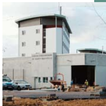
▲ Vue du chantier: la porte d'entrée principale.
