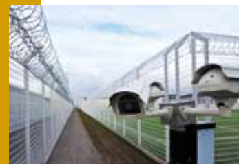
▲ Des caméras assurent la surveillance extérieure.
