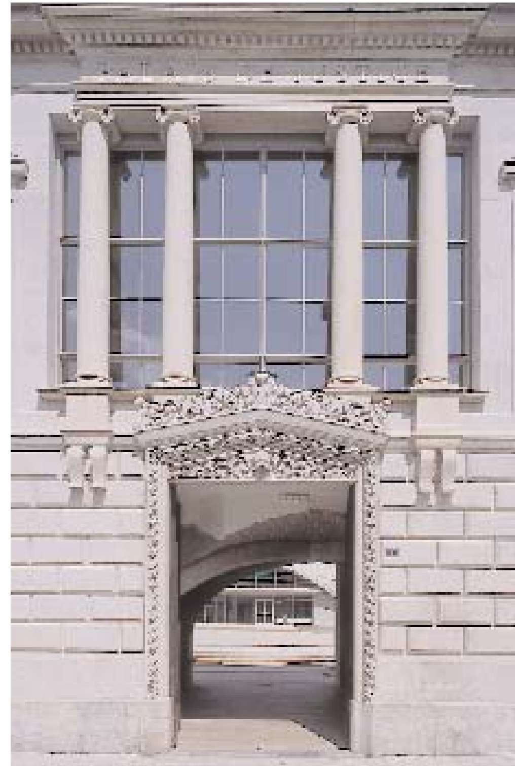
Une loge ionique est créée au-dessus de la nouvelle entrée rue Mégevand (ci-contre et ci-dessus).
