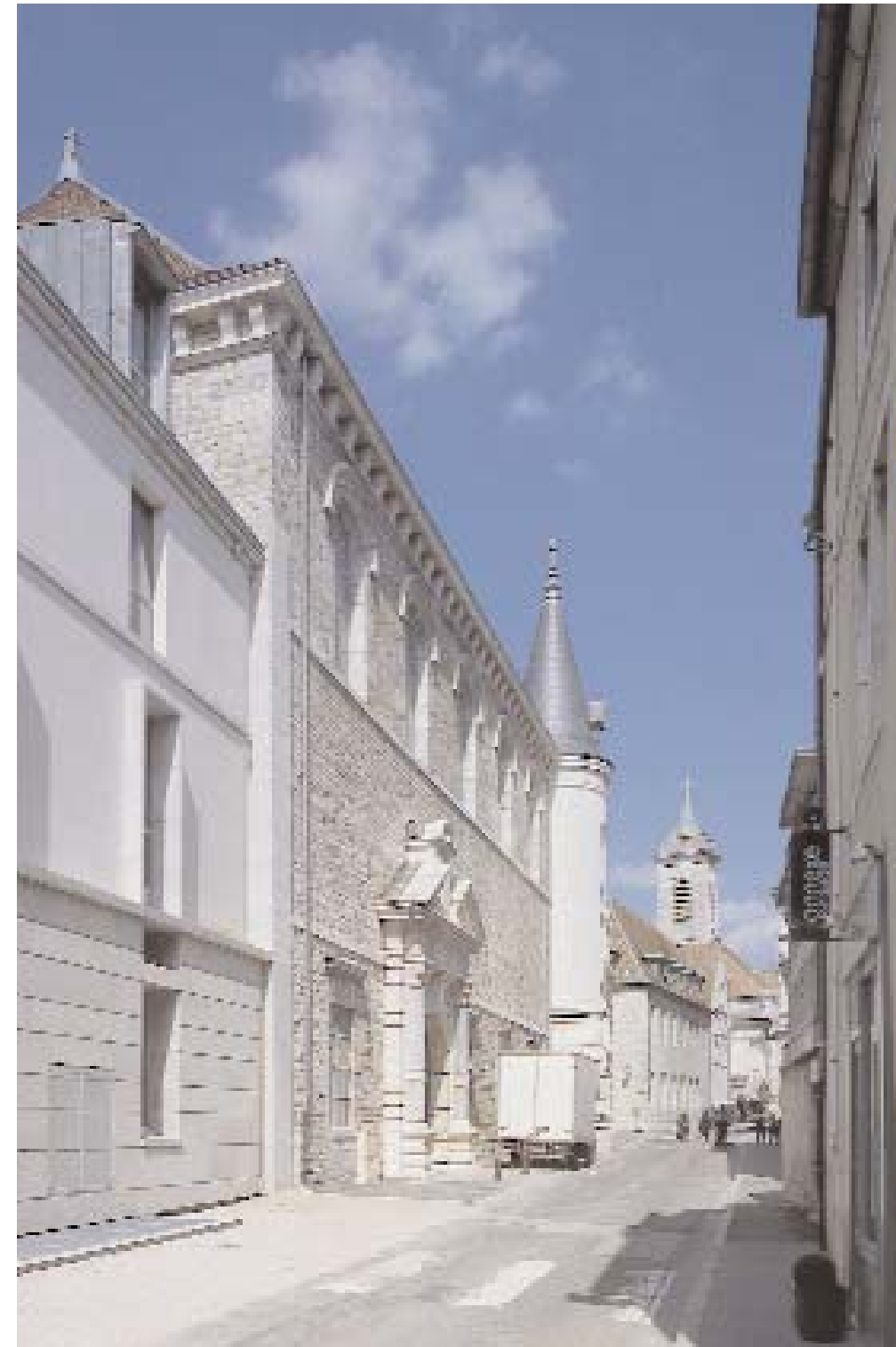
Au premier plan, l'extension du palais de Justice en continuité avec le bâtiment historique.
