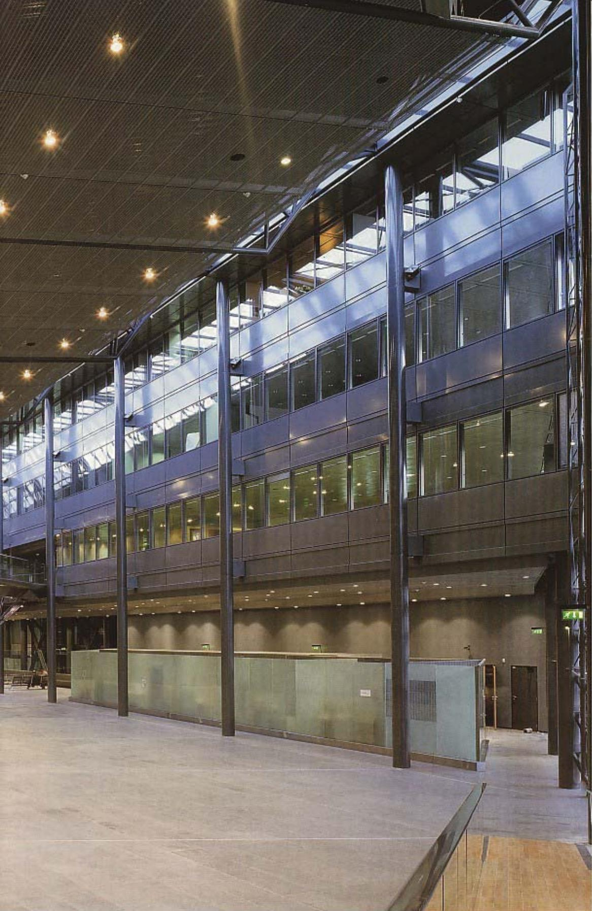
**Les innovations techniques.** Une double peau répond à une triple fonction : protection phonique, protection thermique (été et hiver) et modulation des apports lumineux.
