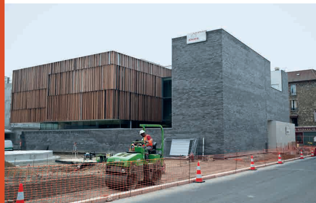
^ Le palais de justice s'intègre dans un quartier en pleine mutation, ici le parvis en cours d'aménagement.
