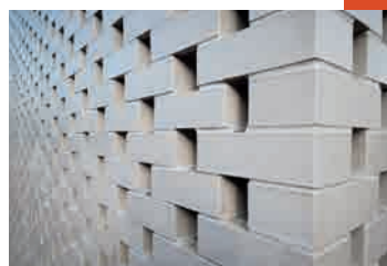
^ Détail de la paroi du bâtiment, ajourée de briques blanches (moucharabieh).
