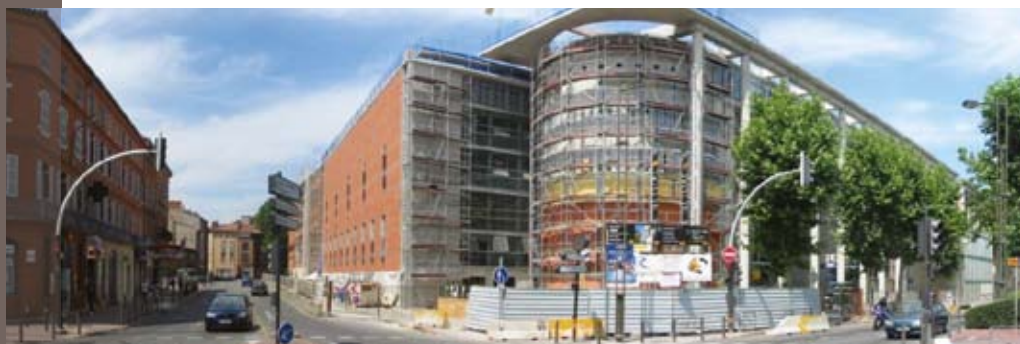
Les grandes étapes du chantier.
