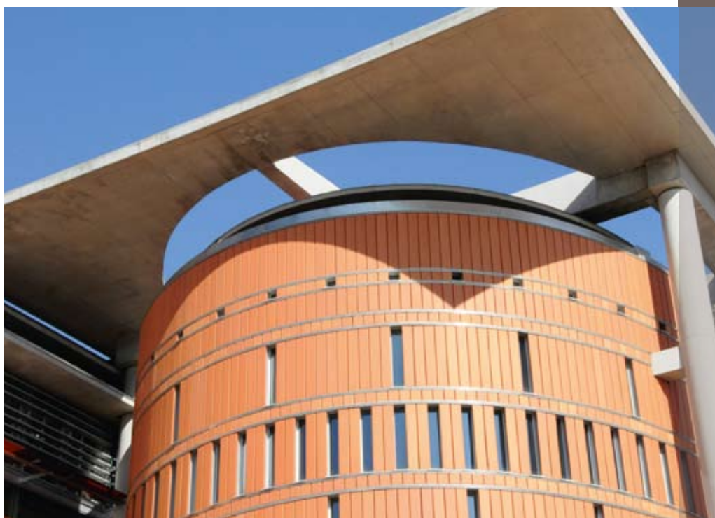
Le volume ovale se détache de la façade, il en est l'élément emblématique.
