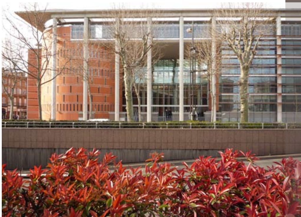
Une des façades du bâtiment.
