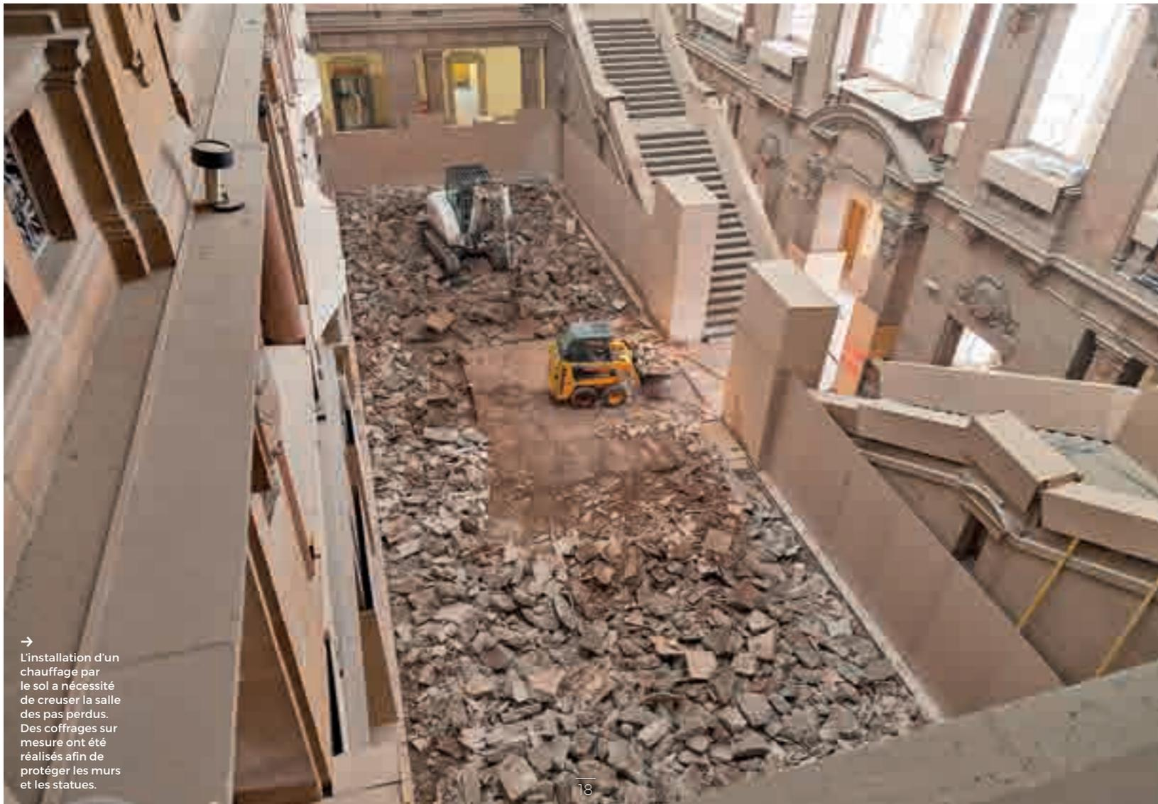
→ L'installation d'un chauffage par le sol a nécessité de creuser la salle des pas perdus. Des coffrages sur mesure ont été réalisés afin de protéger les murs et les statues.
