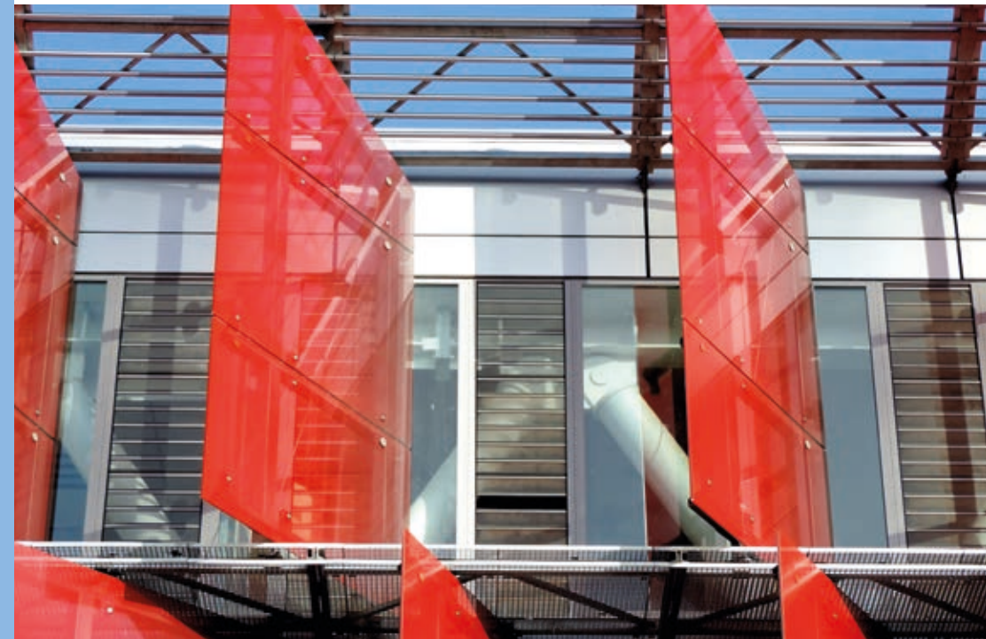
^ Les brise-soleil de la façade ouest permettent à la lumière de pénétrer dans le bâtiment, tout en le préservant de la chaleur.
