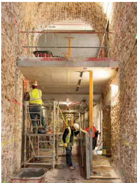
Chantier de la Maison d'arrêt de Paris-La Santé
