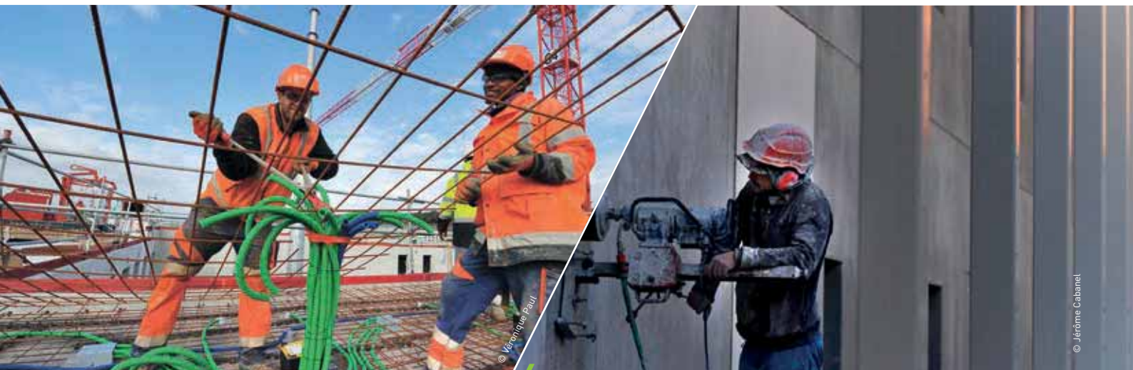
De gauche à droite : chantiers des centres pénitentiaires d'Aix-Luynes 2 (photo 1 et 2), et Marseille-Les Baumettes 2
