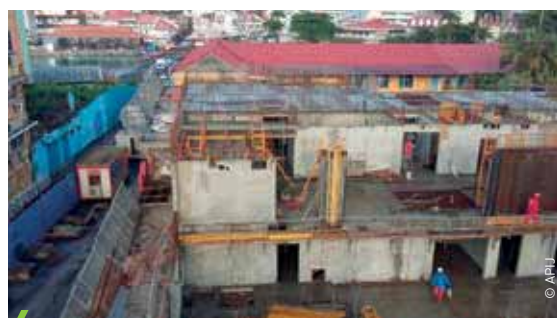
Le chantier du nouveau palais de justice de Pointe-à-Pitre
