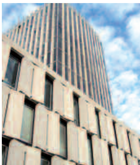
Un immeuble de grande hauteur à rénover
