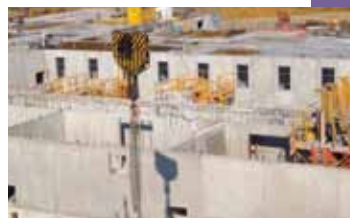
▲ Vue du chantier.
