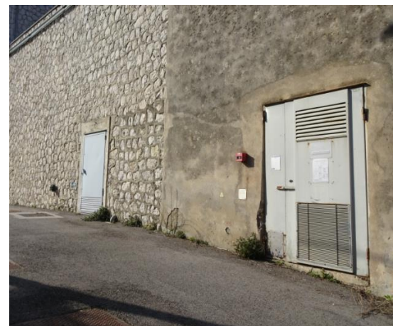
Photographie 7 : Poste de transformation électrique présent dans le mur d'enceinte (source : Egis)
