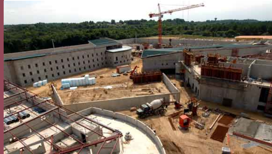
^ Photographies du chantier
