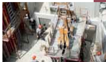
^ 17 km de voiles de béton ont été coulés sur place. >
