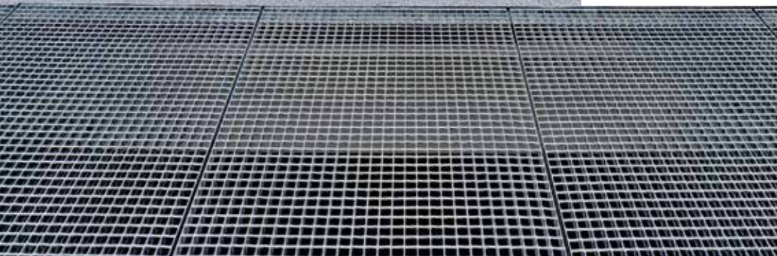
^ Le système de caillebotis au plancher diffuse de la lumière sur les trois étages.
