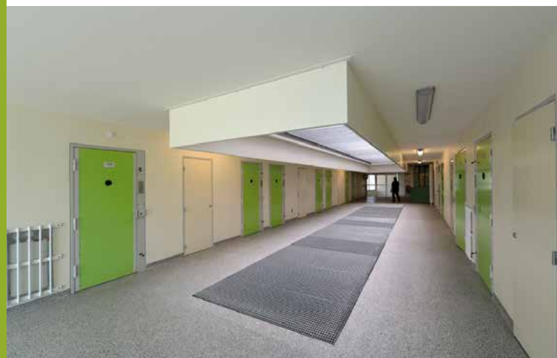
^ Le poste d'information et de contrôle, adapté et moderne, améliore nettement les conditions de travail des personnels.
