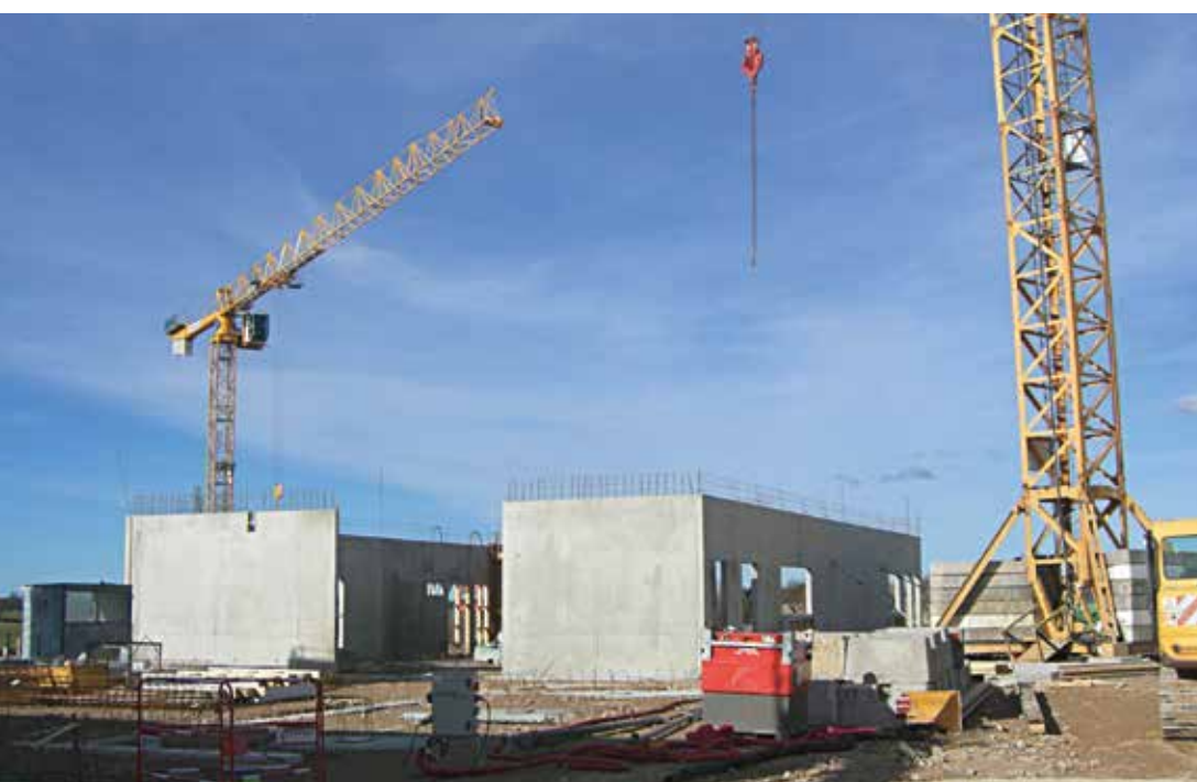
^ ^ L'évolution du chantier de la maison d'arrêt de Rodez.
