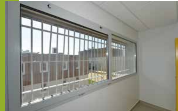
^ Les barreaux sont légèrement inclinés pour rompre la verticalité et apporter plus de courbes.
