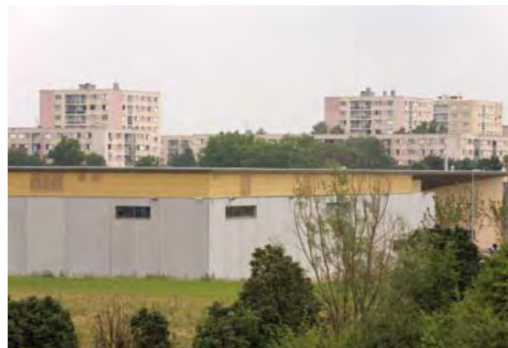
Dumez / Pierre Vurpas et Associés • Le mur exprimé en béton gris clair, entre ombrages et habitations : un bâtiment qui s'imprègne du lieu.
