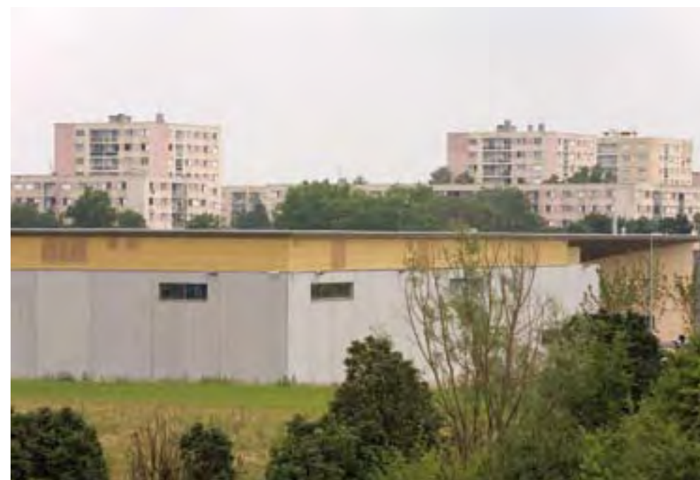
Dumez / Pierre Vurpas et Associés • Le mur exprimé en béton gris clair, entre ombrages et habitations : un bâtiment qui s'imprègne du lieu.
