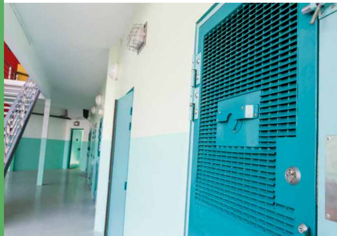
^ Des coursives desservent les nouvelles cellules.
