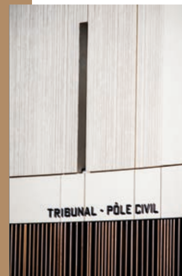
^ Un gommage du béton a été réalisé pour lui donner un effet au plus proche de la pierre du palais Montaigne.
