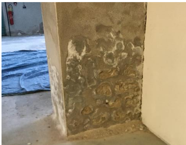
Poteau béton de l'ancienne chaufferie
