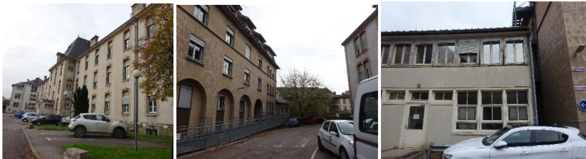
Façade porteuse maçonnée à gauche, bon état général – façade porteuse, poteaux bois et remplissage, état vieillissant
