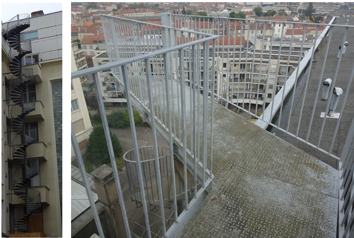
Escalier de secours métallique du bâtiment A pour la surélévation du R+5
