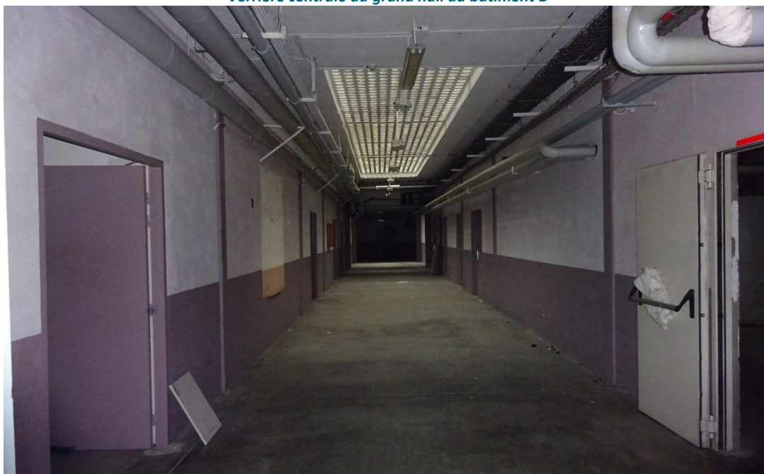
Couloir du sous-sol sous le grand hall
