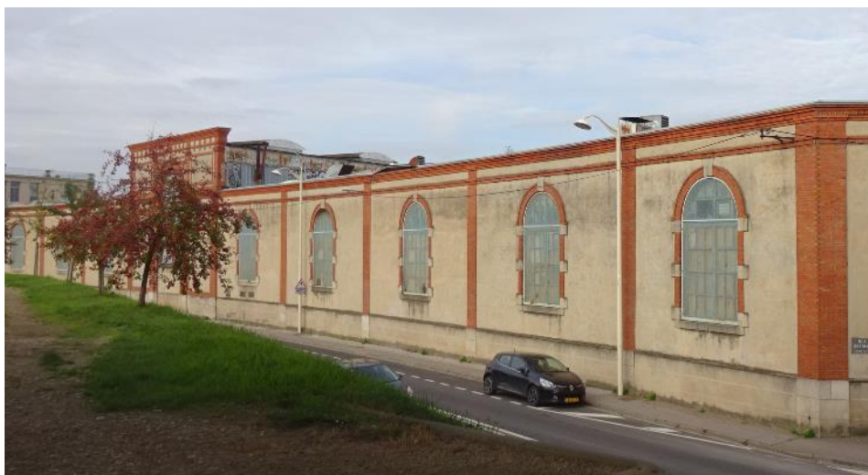
Façade de la halle de montage
