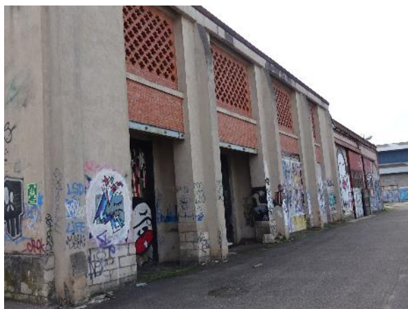
Façade Nord de l'ancien atelier de réparation
