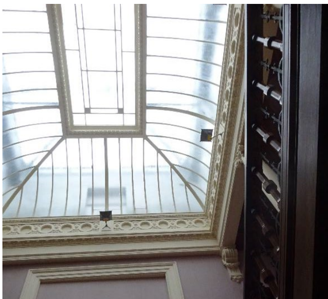
Verrière centrale et escalier en bois
