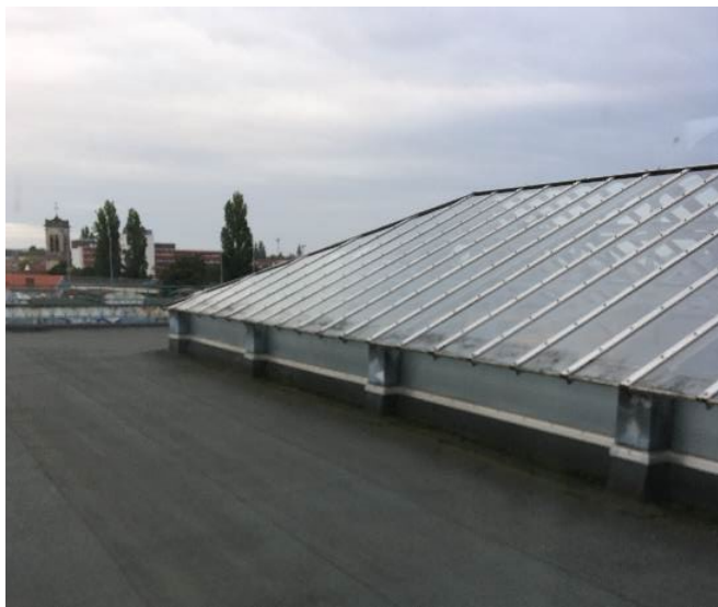
Toiture du bâtiment administratif
