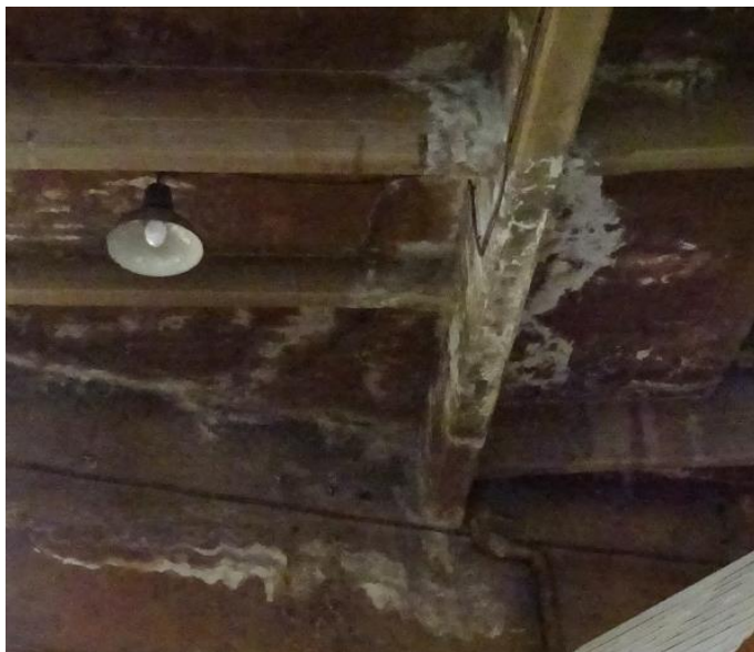
Nombreuses infiltrations en toiture de l'ancien atelier de réparation
