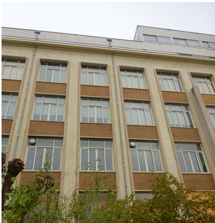
Façade porteuse et surélévation du bâtiment A
