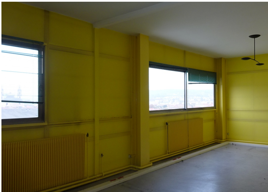
Surélévation du bâtiment A
