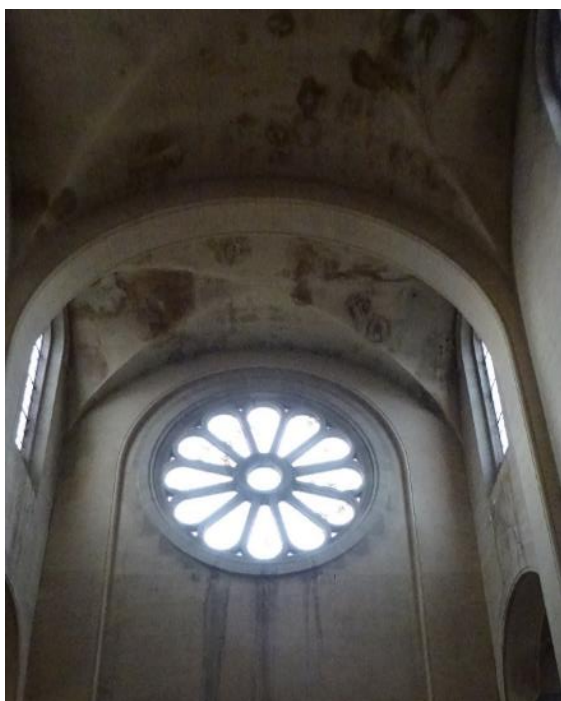
Traces dues à des infiltrations
