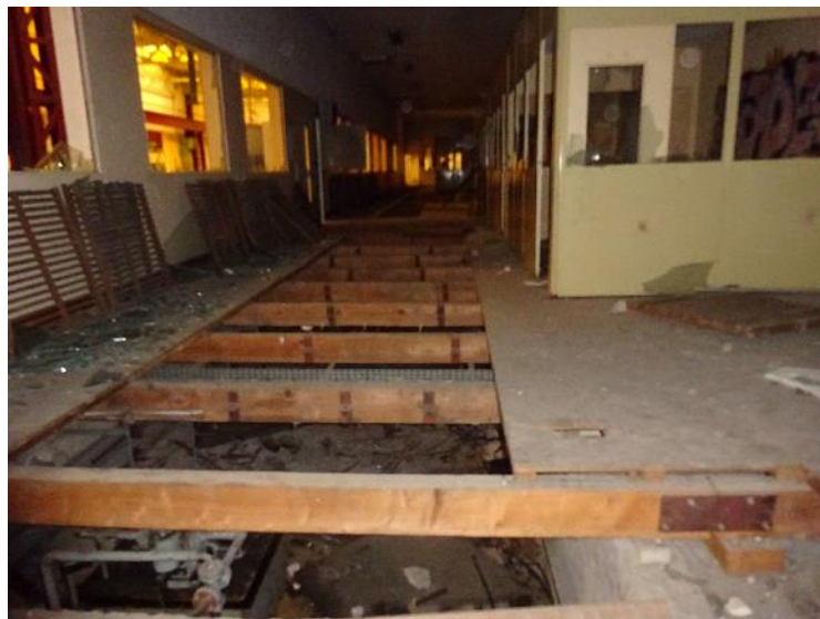
Décaissé dans la dalle
