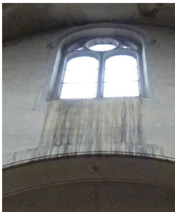
Traces dues à des infiltrations
