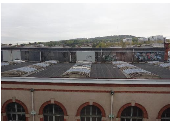
Toiture plate en panneaux fibrociment avec files de lanterneaux en polycarbonate et tôle ondulée
