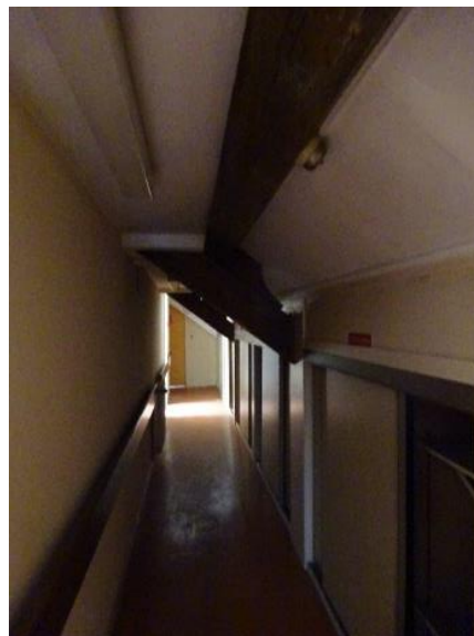
Espace aménagé dans les combles du bâtiment J03
