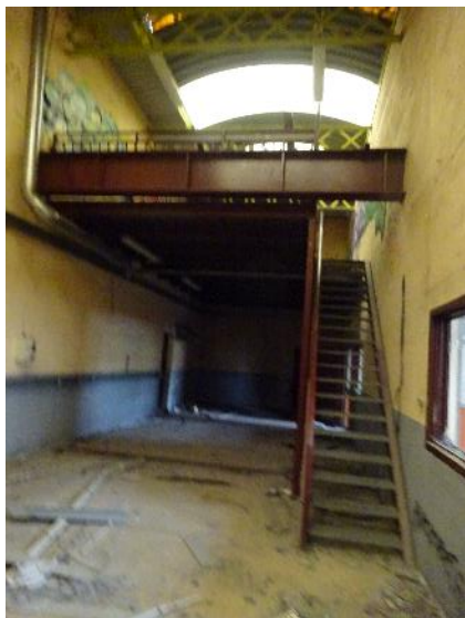
Création de mezzanine
