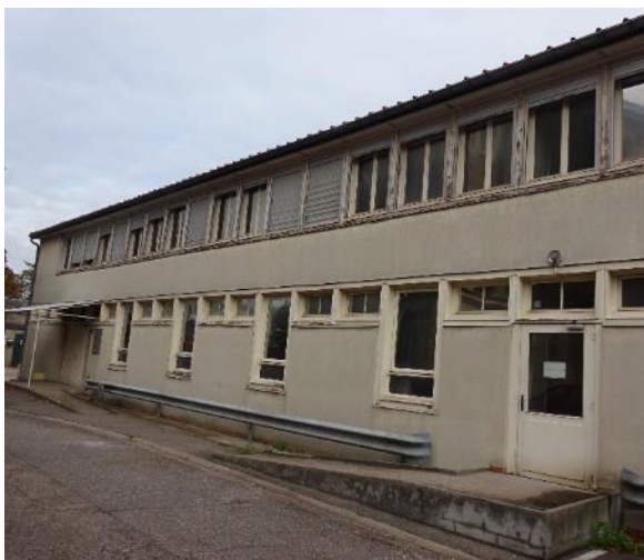
Façade du bâtiment Ex-services techniques (J18)
