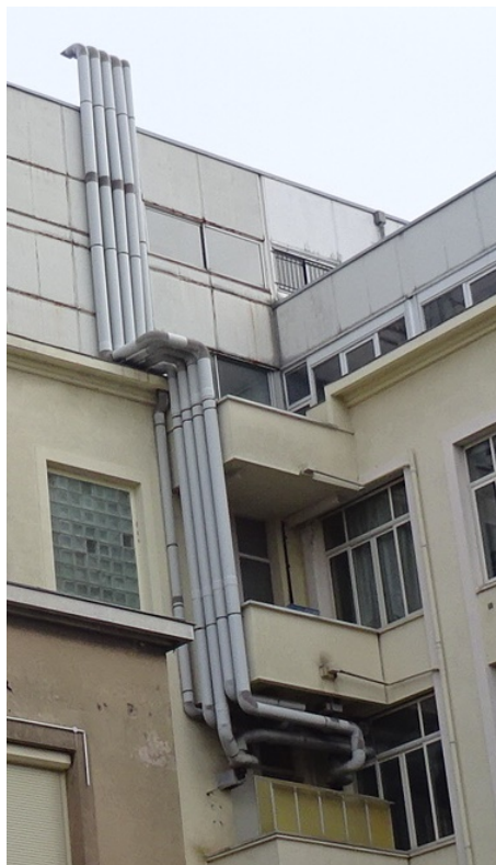
Ajouts de gaines de ventilation des laboratoires dans le bâtiment A
