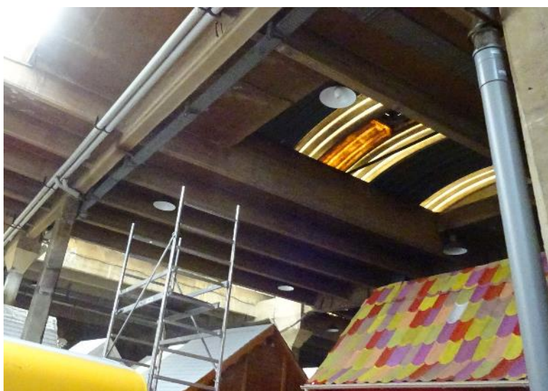
Structure poteaux-poutres béton de l'ancien atelier de réparation
