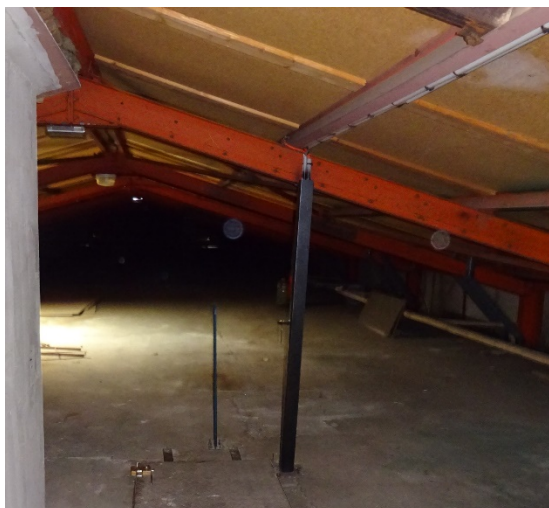
Charpente du bâtiment C
