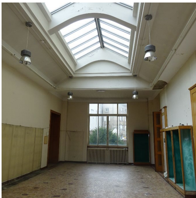
Verrière de liaison entre les bâtiments B et C
