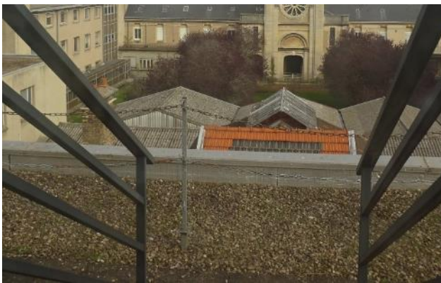
Toiture-terrasse de l'extension du Pavillon Spillmann et vue sur la toiture en pans du restaurant du personnel
