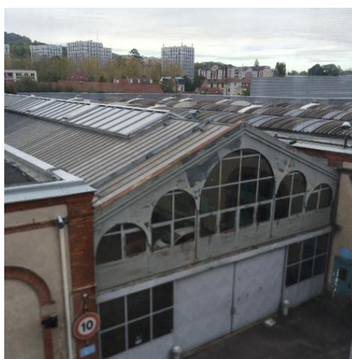
Toiture à deux pans avec lanterneau vitré au faîtage du hall d'entrée
