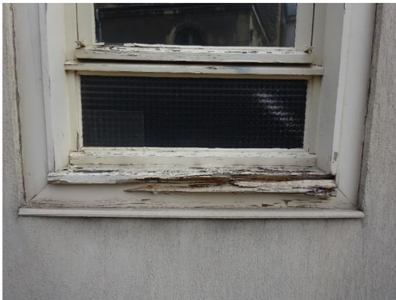
Menuiserie bois du bâtiment J18
