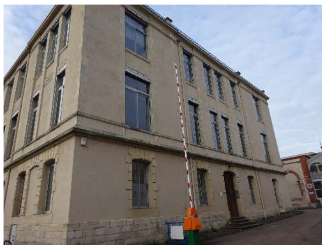
Façade du bâtiment administratif
