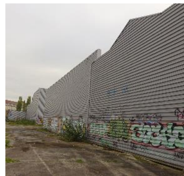
Pignons des bâtiments d'exposition, hall d'entrée et halle de montage
