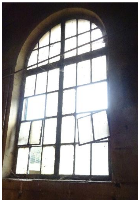
Menuiseries en mauvais état
