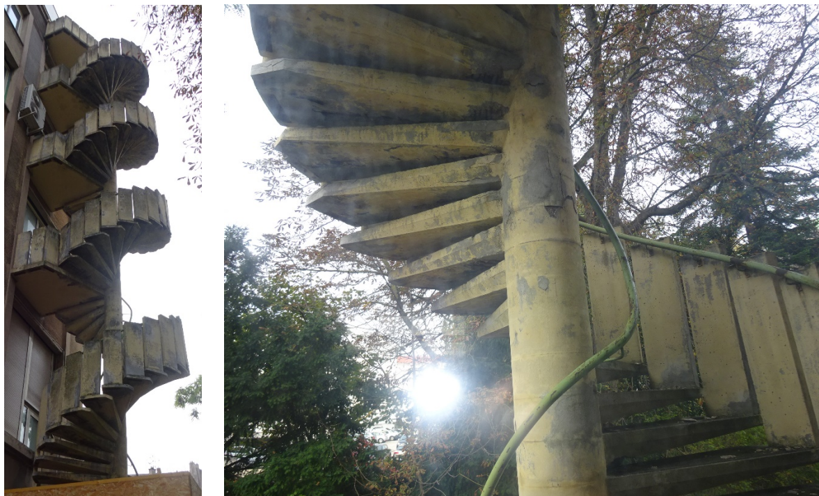
Escalier de secours béton des bâtiments A et C
