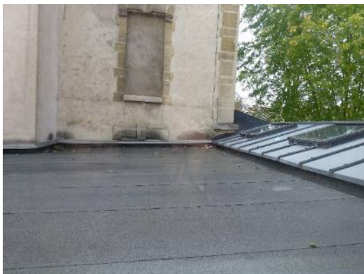
Couverture du bâtiment entre J01 et J02
