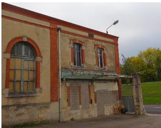
Angle Sud-Est de la halle de montage
