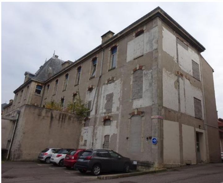
Façade du bâtiment Ex-neurologie (J04, inoccupé)
