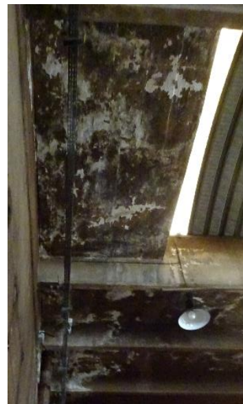
Nombreuses infiltrations en toiture de l'ancien atelier de réparation
