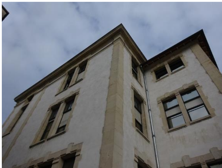
Façade du Pavillon Spillmann (J01)
