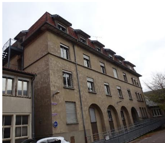
Façade du bâtiment Thomas Becquet (J19)
