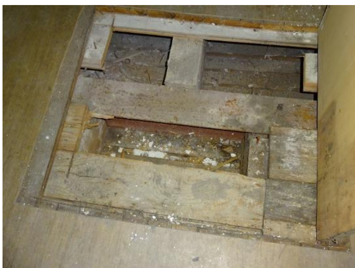
Sondage réalisé dans un plancher bois
