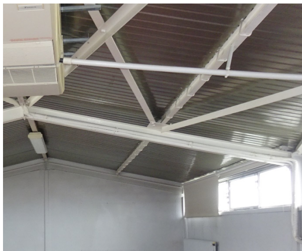
Charpente de l'ancienne serre au R+5 du bâtiment C
