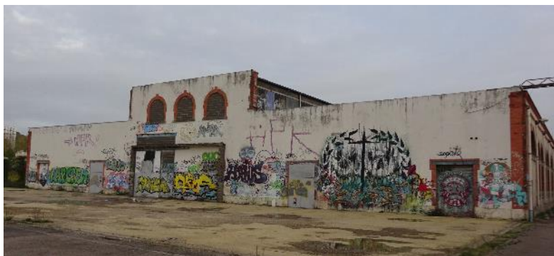
Pignon du bâtiment d'exposition (ancien hall d'usinage)
