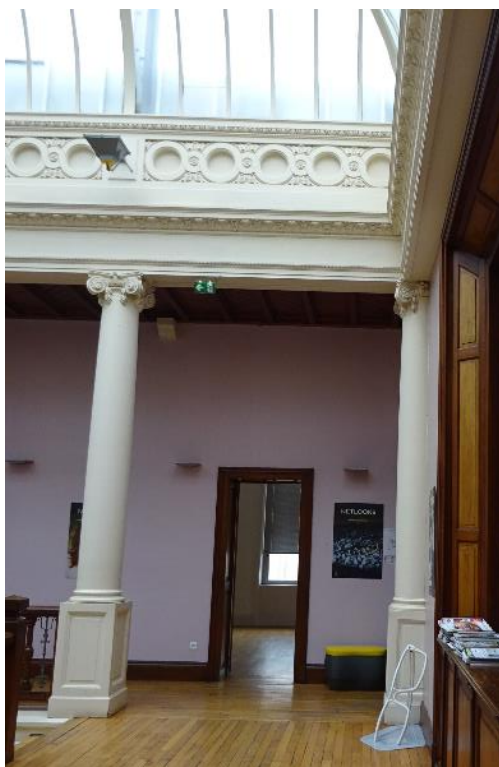
Colonnes supportant la verrière centrale
