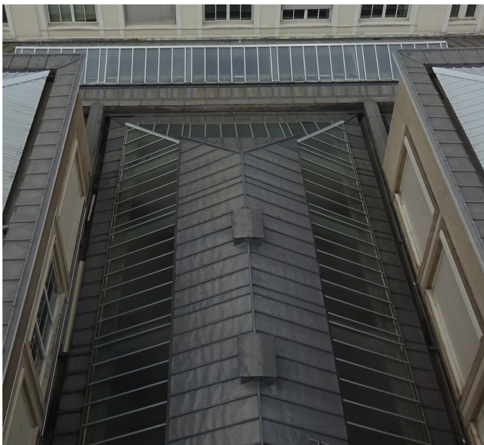
Verrière centrale (grand hall) du bâtiment B et verrière de liaison entre les bâtiments B et C
