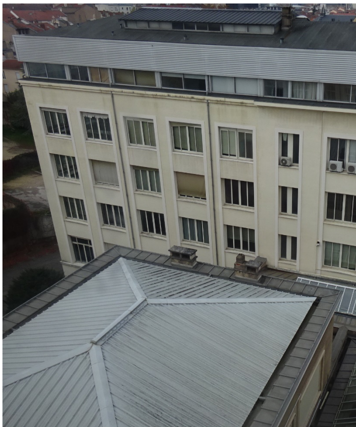
Couvertures zinc d'un amphithéâtre et du bâtiment C et couverture métallique de l'ancienne serre du bâtiment C
