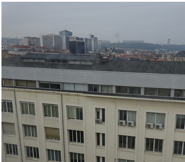
Surélévation des bâtiments A et C
