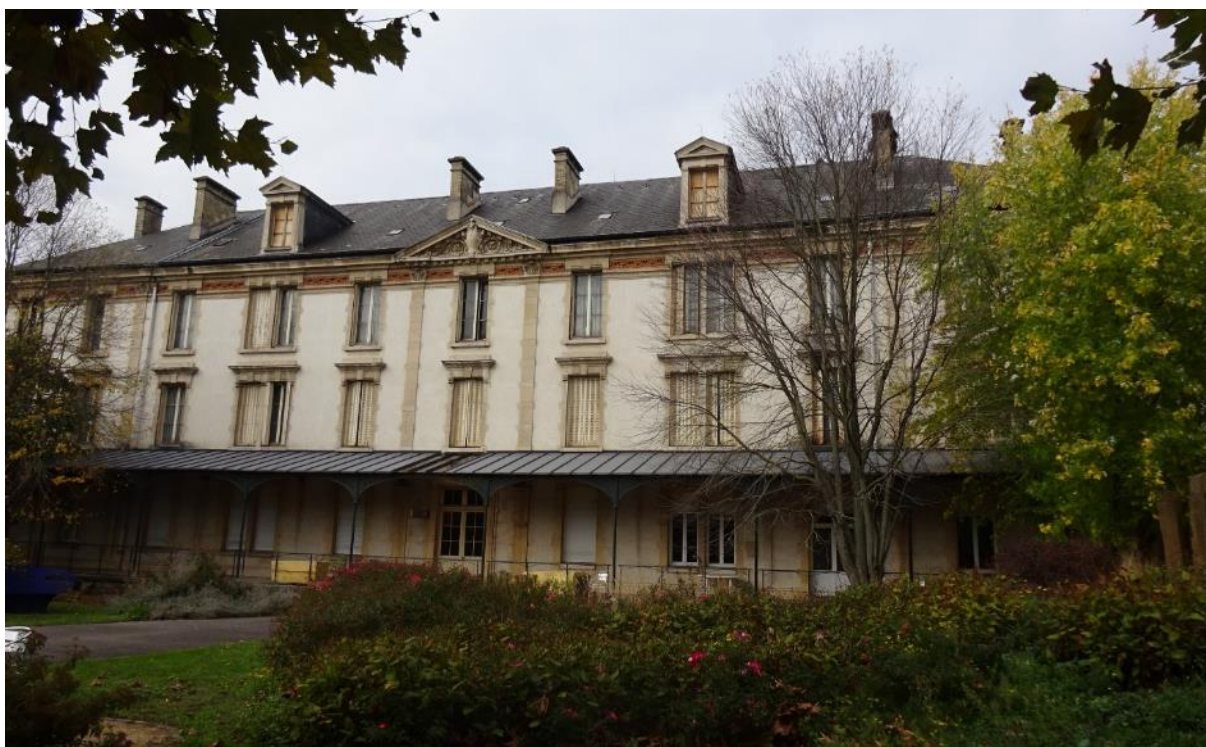
Façade porteuse maçonnée – bon état général
