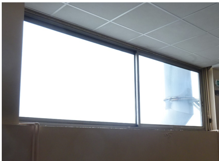
Fenêtre coulissante de la surélévation du bâtiment A
