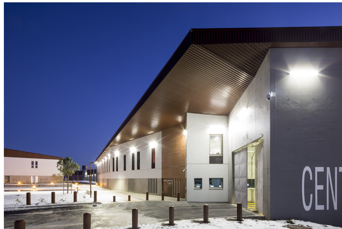
Le Centre pénitentiaire d'Aix-Luynes 2
