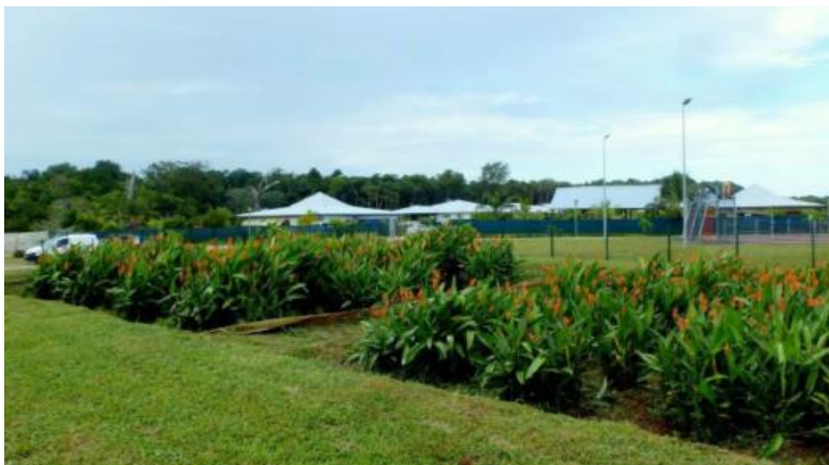
Figure 27 -Filtre planté de bois d'opale à Macouria - 700 EH
