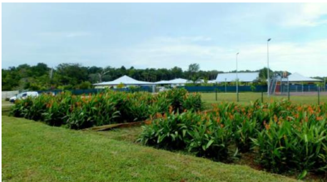
Figure 12 -Filtre planté de bois d'opale à Macouria - 700 EH
