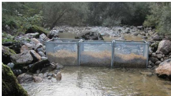
Figure 156 - Exemple filtre grillagé contenant de la paille
