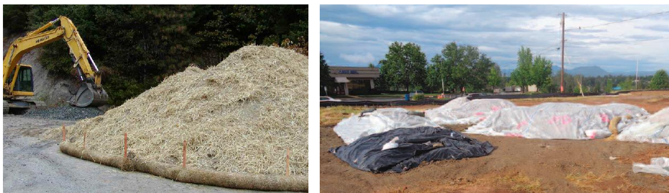
Figure 158 - Exemples de protection des dépôts provisoires à l'aide de paillage par mulch (à gauche) et de géomembranes (à droite) [Guide des bonnes pratiques environnementales – Protection des milieux aquatiques en phase chantier, AFB, 2018]
