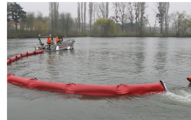
Figure 157 - Exemple de barrage flottant anti-pollution
