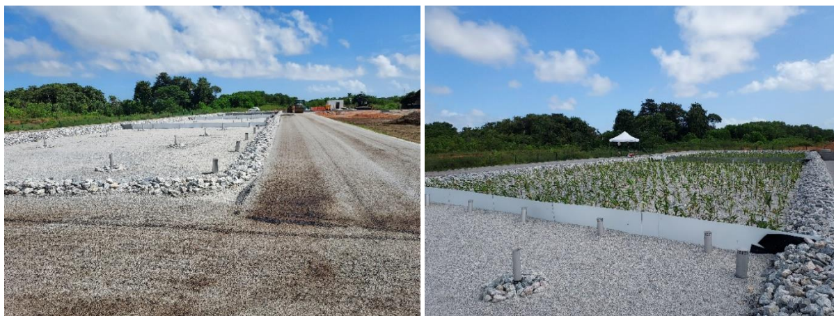
Figure 25. Filtre planté de Maillard en cours de construction
