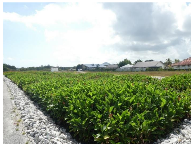
Figure 26. Photos de filtres plantés de Heliconia psittacorum et Cana glauca (@ETIage Guyane, Maillard CACL)
