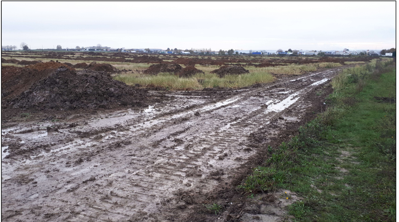
Photographie du chemin d'accès au chantier. Le chemin borde la maison d'arrêt de Villepinte. (Source : DEKRA)
