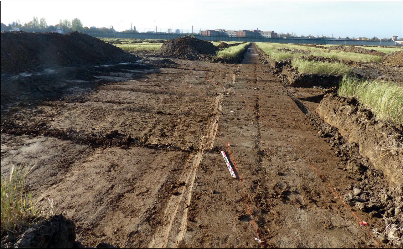
Fig.52 Vue générale des croisements de fossés 8.08, 8.09, 8.218 et 8.10.
