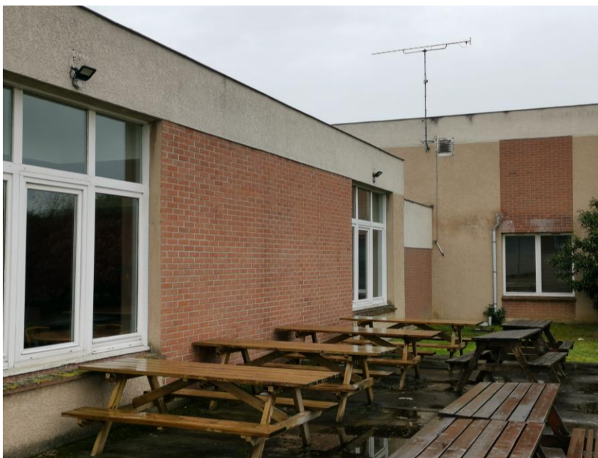
FIGURE 14 : BATIMENT A DEMOLIR DANS LE CADRE DU PROJET (APIJ, MARS 2024)
