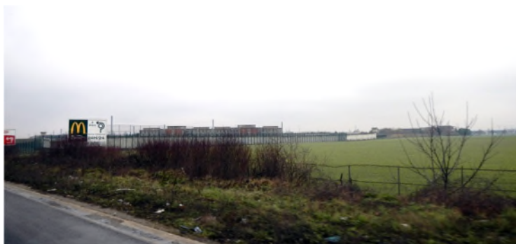
Vue n°10 : Vue proche et dégagée sur le site de la Francilienne. (Source : Egis, février 2018)
