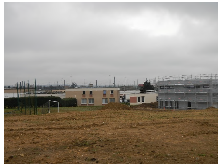
Bâtiments annexes de la maison d'arrêt de Villepinte (Source : Egis, Février 2018)
