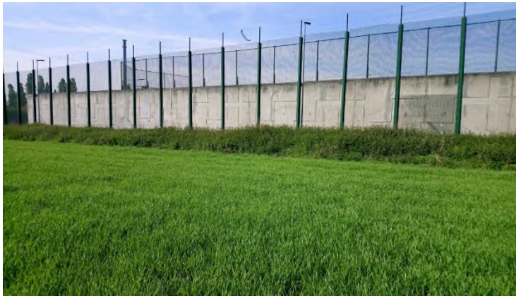
Ourlet rudéral le long de la maison d'arrêt (Source : Egis, 2019)
