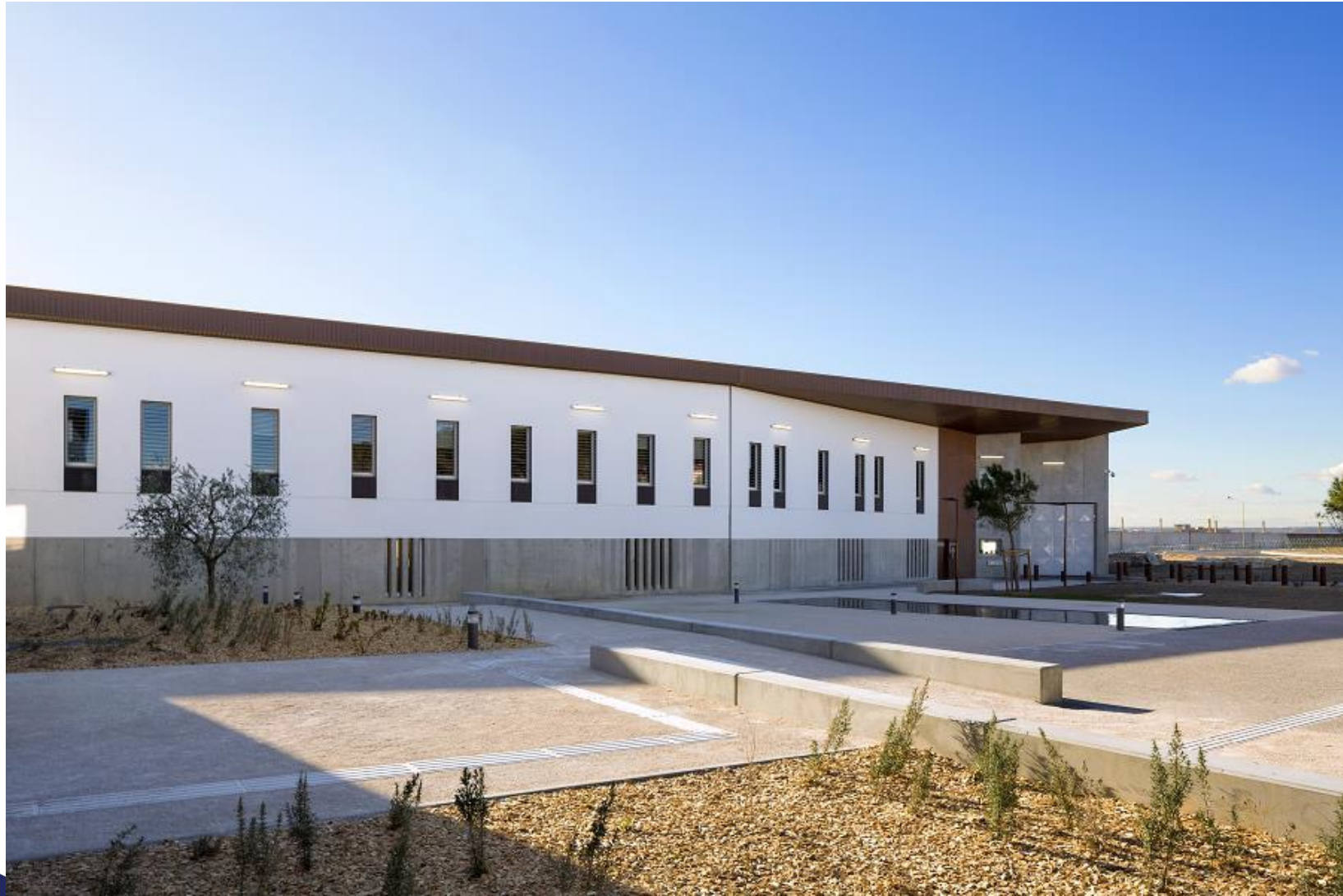
Centre pénitentiaire d'Aix-Luynes 2
