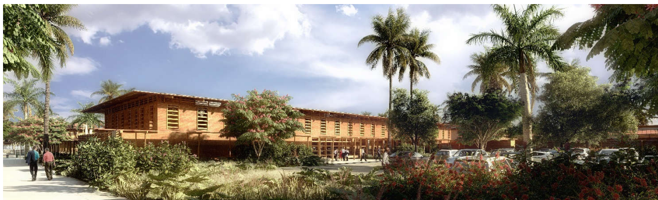
Vue depuis le parking visiteurs commun au Tribunal et au SPIP-PJJ, vers le bâtiment SPIP-PJJ.
