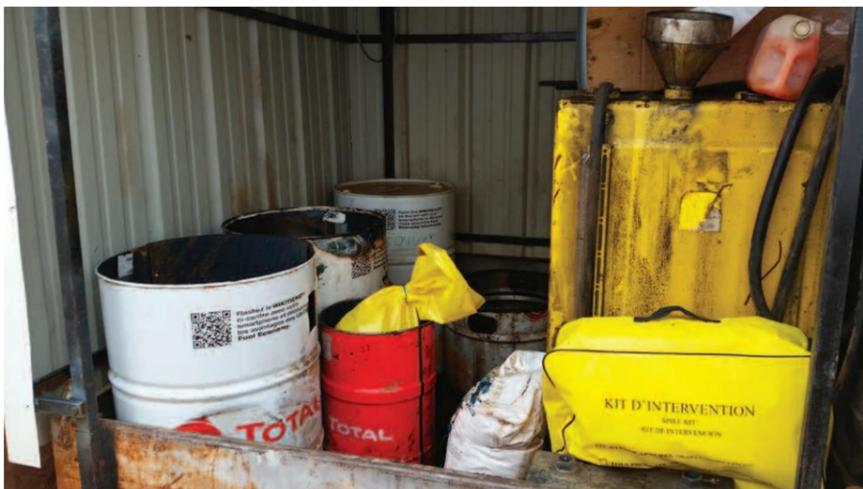
Figure 58: Exemple d'aire de stockage pour matériaux polluants (Source : Guide technique "Protection des milieux aquatiques en phase chantier", AFB, 2018)
