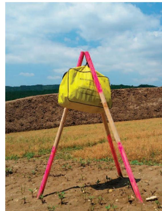
Figure 59 : Exemple d'un kit anti-pollution isolé du sol (Source : Eiffage)
