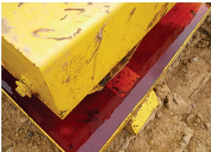
Figure 56: Groupe électrogène avec cuvette de rétention non vidée et risque de débordement (Source : Guide technique "Protection des milieux aquatiques en phase chantier", AFB, 2018)
