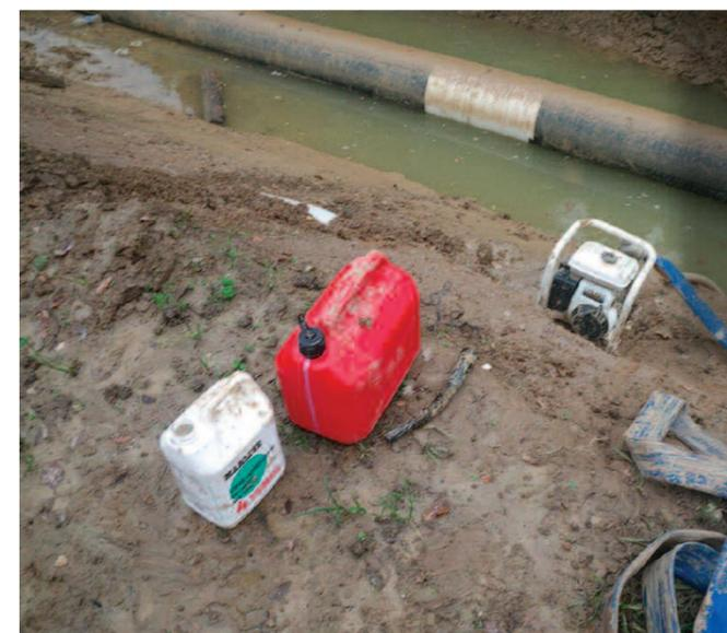
Figure 55: Stockage de bidons proche d'un milieu aquatique avec risque de déversement accidentel et groupe électrogène sans cuvette de rétention
