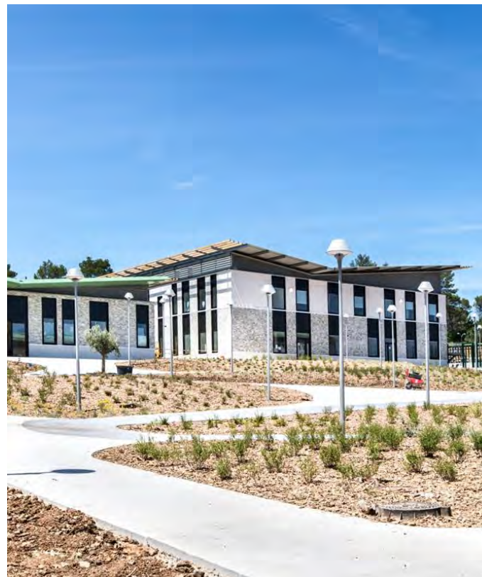
Centre pénitentiaire de Draguignan
