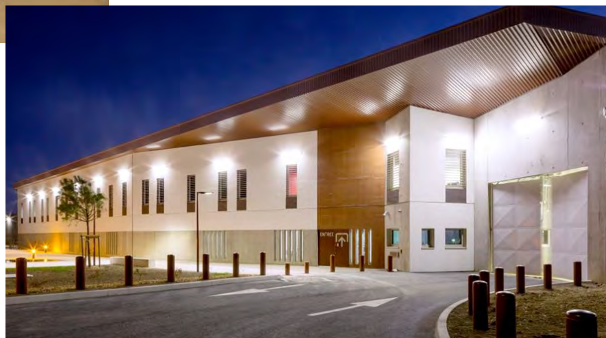
Centre pénitentiaire Aix 2
