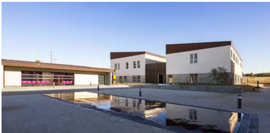
Centre pénitentiaire Aix 2
