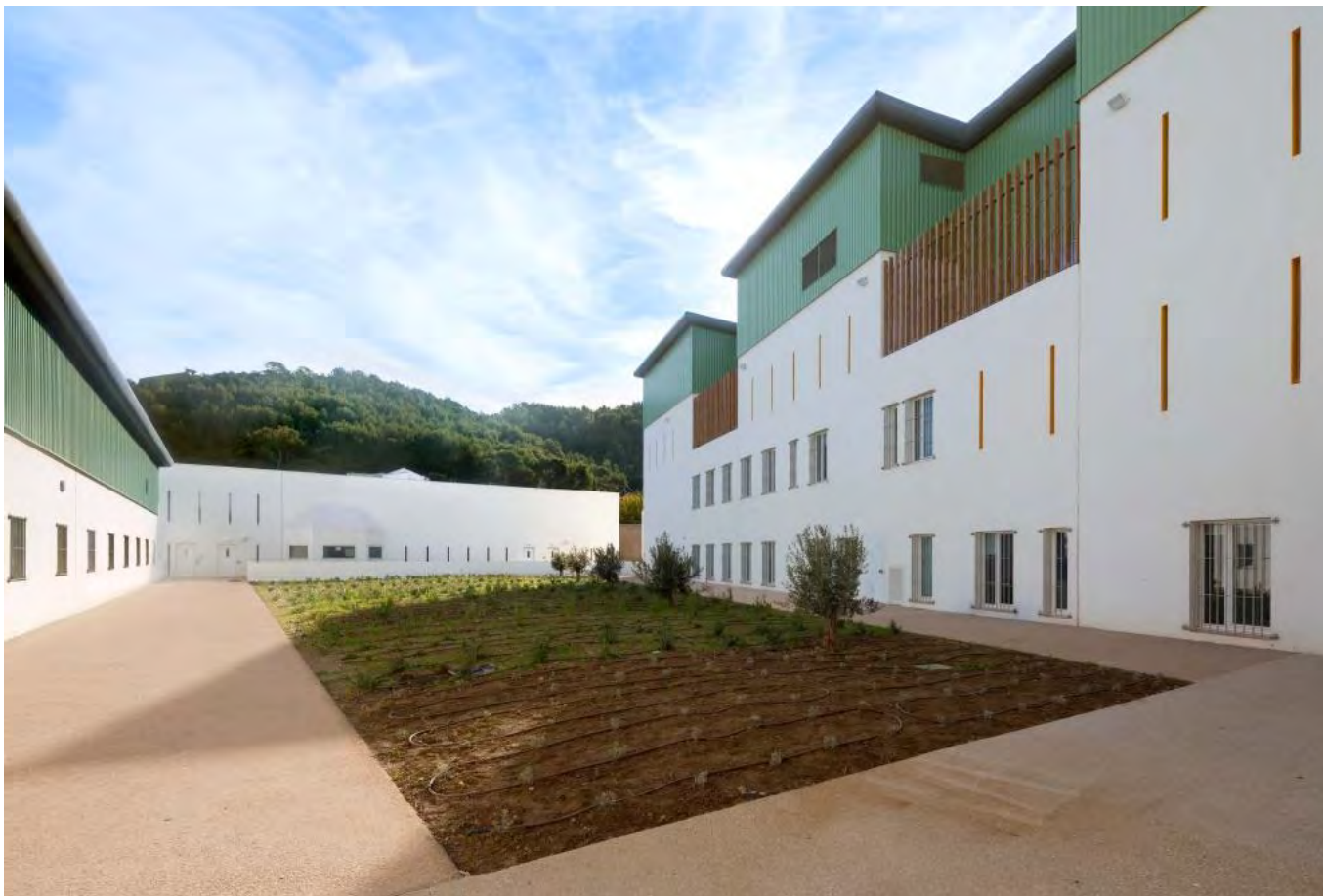
Centre pénitentiaire Baumettes 2
