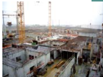
^ > Le chantier de la maison d'arrêt.
