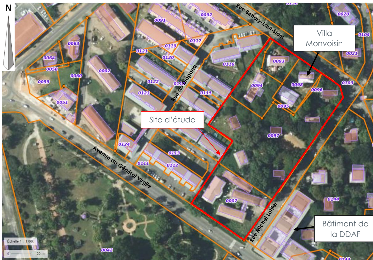
Figure 2 : Photographie aérienne de la zone d'étude (source : www.geoportail.gouv.fr)
